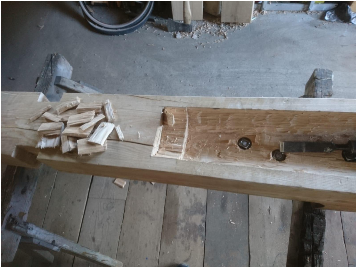
Feinarbeiten mit dem Stemmeisen und Ausarbeiten der Seitenlager für das Richthorn
